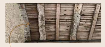
Cette photo montre l'état d'une partie de la charpente, où des trous sont apparents.
